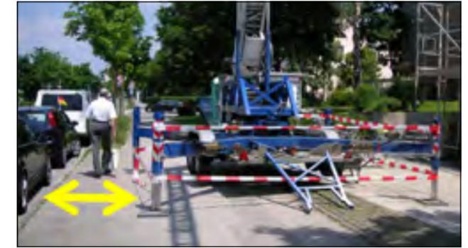
eines Blinden zumindest einen kleinen Widerstand spürt. Während der gesamten Dauer des Einsatzes ist darauf zu achten, dass sich die Warnbänder nicht lösen und im Gehwegbereich flattern. Besser geeignet wären Tastkanten, die an den Aufstellfüßen des Kranwagens befestigt werden.
