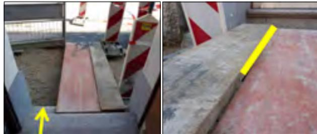
Bei Hauszugängen darf keine Lücke entstehen. Die Abdeckung muss über die ganze Türbreite erfolgen. Bei Abdeckungen aus unterschiedlichem Material oder mit unterschiedlicher Dicke besteht die Gefahr mit dem Fuß umzuknicken.
