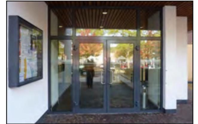
*Die Spiegelungen an der Eingangstüre zum Bühnhaus sind so stark, dass die weißen Markierungen der Glasscheiben, die auf der Innenseite der Scheibe angebracht sind, nicht erkannt werden.*
