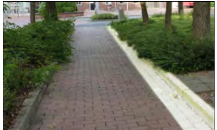
Verzichtet man auf Rippenplatten als Leitsystem insgesamt an dem Platz, so können die Beeteinfassungen als Orientierung dienen. Dazu sollten diese mit 8 cm Höhendifferenz eingebaut werden. Bei weniger Höhe hat sich gezeigt, dass der Grünbewuchs aus den Beeten in die Wege wächst und damit seine Funktion verliert. Vor der Beeteinfassung soll ein **weißer** Streifen von ca. 30 cm angelegt werden.
