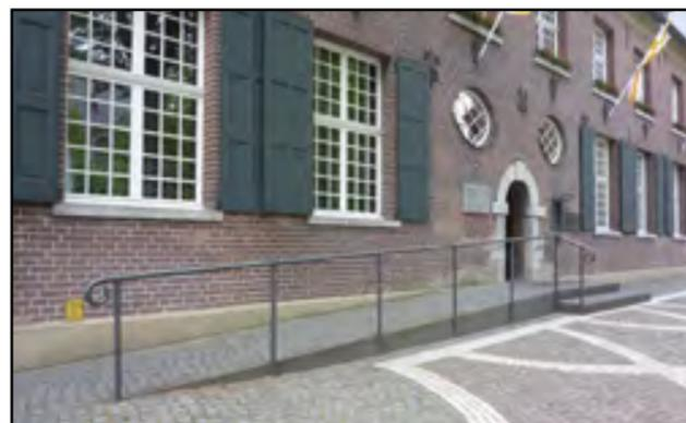
Rampe im Einklang mit der denkmalgeschützten Umgebung. Was fehlt ist ein Radabweiser und eine kontrastreiche Markierung des Rampenbeginns sowie der Stufen.
