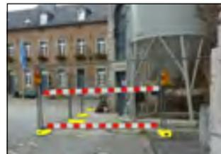
Um Bauzäune sichtbar zu machen, sollten erstens die Baufüße gelb eingefärbt sein und zweitens unten und in 1,00 m Höhe rot - weiße Markierungen angebracht werden. Dies kann zum einen durch eingewebte Markierungsbänder erfolgen oder
