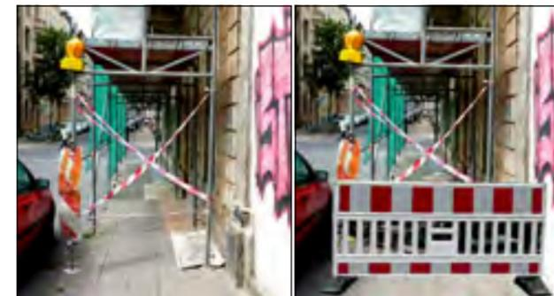
Ist eine Vollsperrung des Gehweges unter einem Gerüst erforderlich, so sind Absperrbänder nicht ausreichend. Eine Absperrschranke sollte den Durchgang deutlich verhindern. Möglichkeiten zum Wechsel der Straßenseite müssen für alle geschaffen werden (gelbe Kurzrampen).
