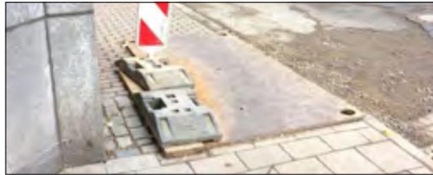
Metallplatten sind stabil, sollten aber mit gelb markierten Anrampungskeilen versehen werden, da die scharfe Kante mit einem Rollstuhl kaum zu überwinden ist. Eine Barke macht auf die Unebenheit aufmerksam. Der Baufuß, der zur Beschwerung auf der danebenliegenden Holzbohle liegt, wird in der Dunkelheit, bzw. bei schlechtem Sehvermögen nicht wahrgenommen und stellt eine Stolpergefahr dar.
