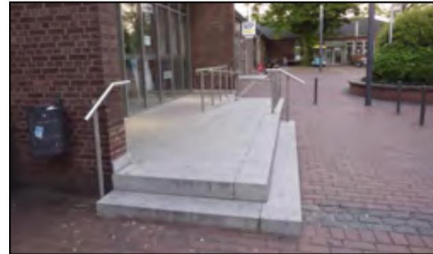
*Fast perfekt - Rampe vor dem Bahnhofsgebäude: Einzig der fehlende Kontrast zwischen der oberen Ebene und den Stufen bzw. der Rampe sollte verbessert werden.*
