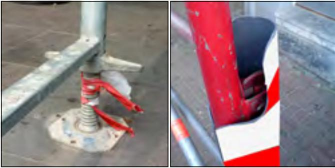
Für Verbindungselemente, wie z. B. Spindeln, die in Fußknöchel oder Kopfhöhe (auch Kinder) hineinragen, sollten Schutzkappen aus Kunststoff mit rot-weißer Markierung angebracht werden.
