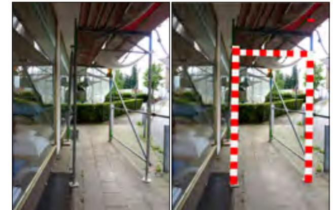
Gerüststangen, die mitten im Gehwegbereich stehen, sind nicht zu erkennen. Sie sollten eine rot-weiße vertikale Markierungslatte, die mindestens 10 cm breit ist, erhalten.
