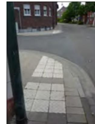
*Beispiel Schanzstraße: Derzeit ist die Nullabsenkung mit dem Blindenleitsystem verknüpft. Dies ist sowohl für Menschen mit Rollstuhl / Rollator unangenehm, wie auch für Blinde. Zudem fehlt der dunkle Kontraststreifen.*
