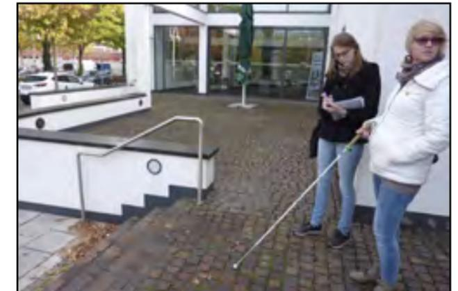
Die Treppenstufen vor dem Bühnenhaus sind mit dem Blick nach unten nicht zu erkennen. Hilfreich dagegen ist der Handlauf und die weiße Mauer mit dem dunklen Sockel. Hier erkennt man die Stufen.
