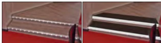
Lichtleisten haben auf Treppenstufen nichts zu suchen. Besser ist ein kontrastreicher Stufenbelag und die Markierung an der Vorderkante mit einer Schiene, die zudem noch eine rutschhemmende Wirkung hat.
