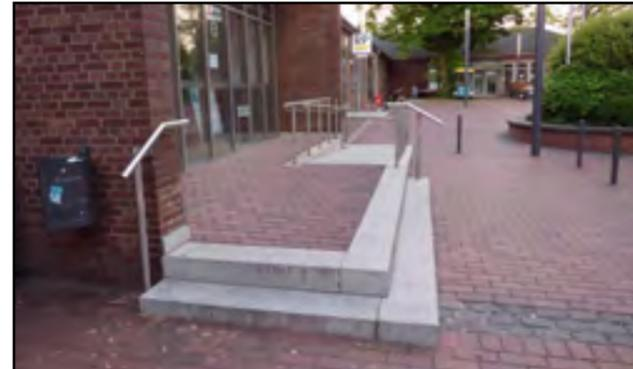
*Möglichkeit 1: Das Podest mit dem gleichen Ziegel-pflaster wie den unteren Platzbereich belegen.*
