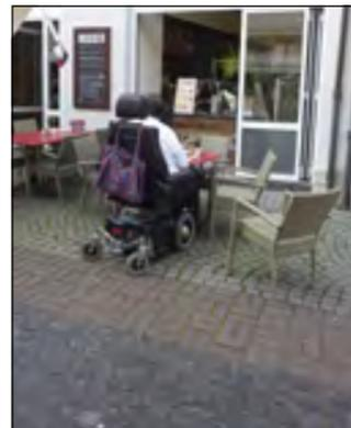
Reflektionsgrad der hellen Muldenrinne muss mindestens 0,5 betragen. Ob zwischen dem Material der Muldenrinne und dem Ziegelklinker der absolute Leuchtdichtekontrast von 0,4 erreicht wird, kann nur mittels einer Leuchtdichtemessung
