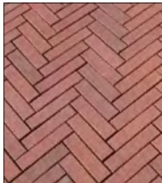
Es sollten Pflastersteine ohne Fasse verwendet werden. Ein Fischgrätverband ist gut geeignet, um auch dauerhaft wachsenden Unebenheiten durch die Belastung von Fahrzeugen zu widerstehen.
