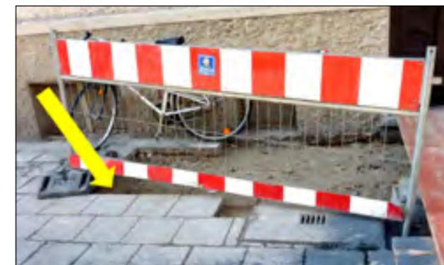
Vor den Absperrgittern dürfen keine Öffnungen im Gehwegbelag sein. Das Gitter muss die Baugrube komplett umschließen.
