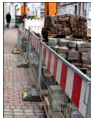
Notgehweges ist jedoch, dass vom Gehweg aus nur die graue Fläche zu sehen ist bzw. nur sehr schlecht gesehen wird. Deshalb sollten diese Metallabsperrschranken nur dort eingesetzt werden, wo die graue Seite zur Baugrube oder zum Materiallagerplatz, also zu einem für die Öffentlichkeit abgesperrten Bereich, eingesetzt werden. Die Füße sind so aufzubauen, dass der kürzere Teil zum Gehweg weist und möglichst mit einer zusätzlichen gelben Tastkante versehen sind.
