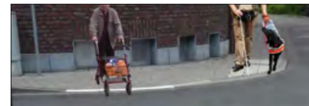
*Besser ist die Trennung mit einer 3 cm-Absenkung und weißem Bordstein für Rollstühle und einem mind. 6 cm hohen weißen Bordstein für Sehbehinderte.*
