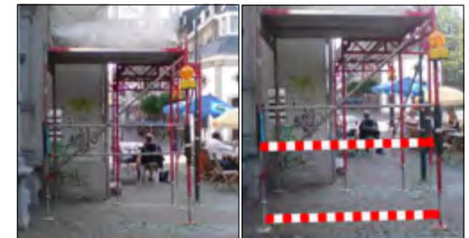
Auch bei horizontalen Stahlrohren, die den üblichen Weg versperren, sollten Markierungsleisten in Bauch-/Kopfhöhe und als Tastleiste max. 10 cm über dem Boden erhalten.
