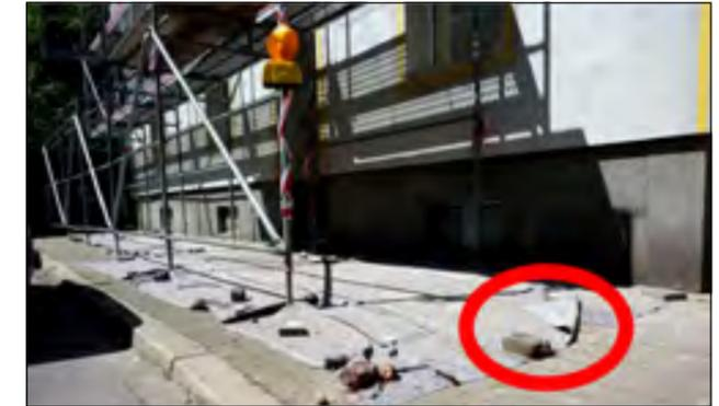
Folien oder Schutzdecken unter einem Gerüst, die den Gehwegbelag vor Verunreinigungen (z. B. Farbe) schützen sollen, dürfen nicht mit einzelnen Steinen „befestigt“ werden, sondern müssen über die ganze Kante am Untergrund fixiert werden.
