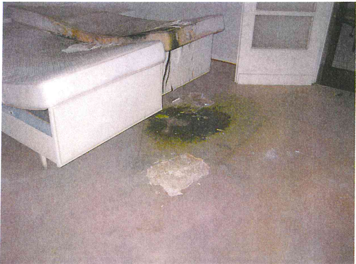
Raum im 1.OG - Flachdachbereich
