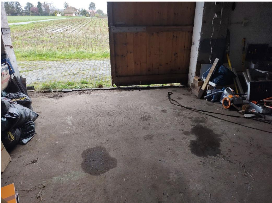
Foto 4: Ölverunreinigung der Betonplatte bei Bohrung RKS 3
