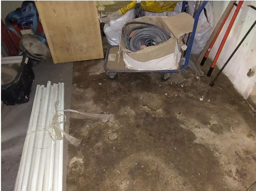
Foto 5: Ölverunreinigung der Betonplatte bei Bohrung RKS 4
